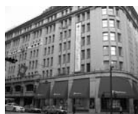
高島屋東京店：昭和8年、日本生命館として建設され、平成21年に百貨店建築初の重要文化財の指定を受けた。西欧様式に和の意匠が見事に調和した昭和の名建築。1階には、東郷青児が扉をデザインしたエレベーターも。
